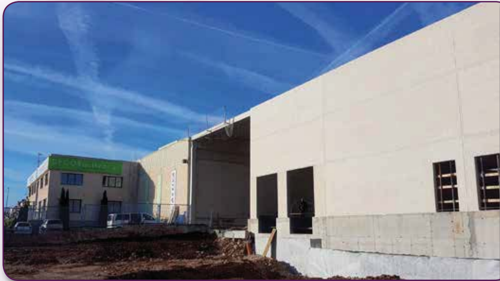
Nuevas instalaciones en estado avanzado de construcción
